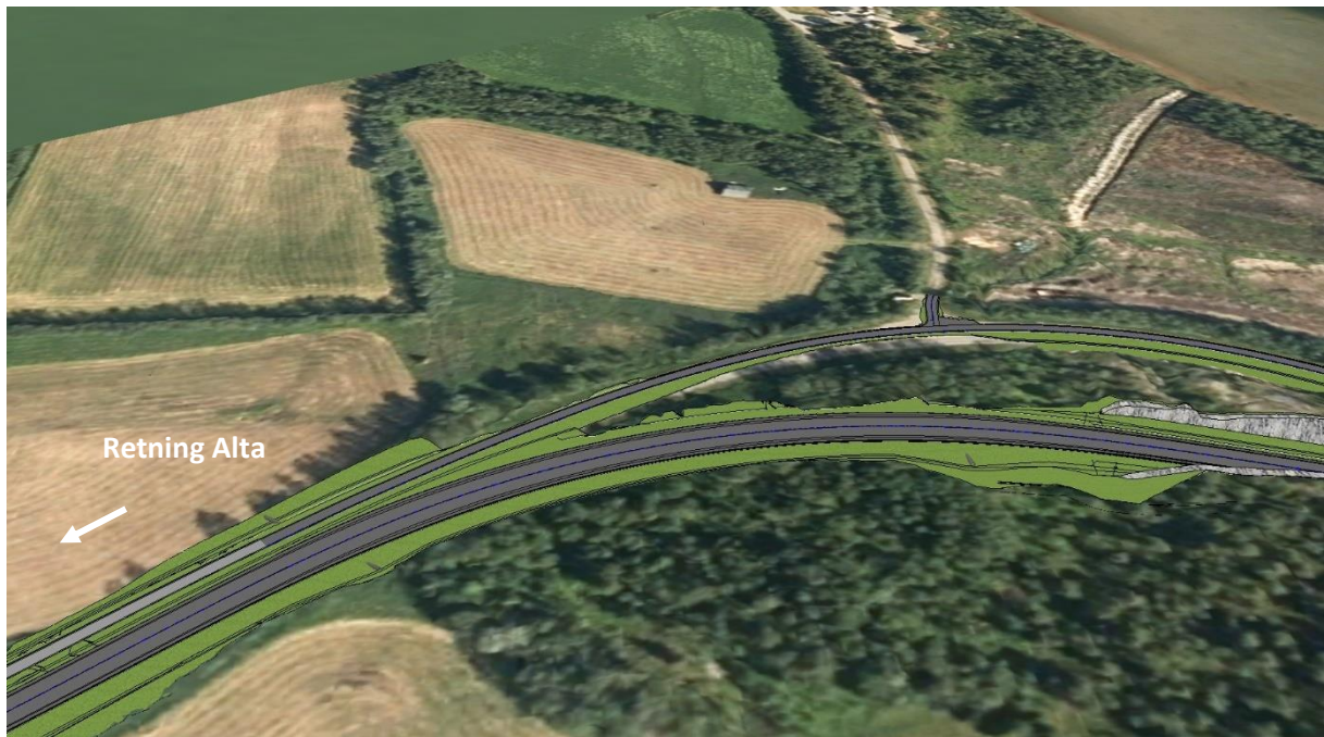
Figur 8: Nærbilde av veganlegget videre østover hvor fremtidig gang-/sykkelveg vil følge dagens vegtrasé, mens E6 vil følge en rettere vegtrasé og legges i bergskjæring (så vidt synlig i lyst grått til høyre i bildet). Bildet er sett mot nord.
