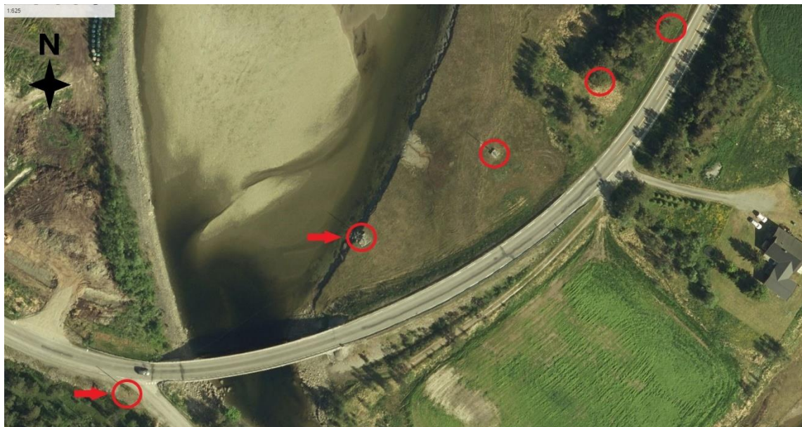
Figur 47: Ortofoto som viser telefonstolper på den vernede linjekursen. Stolpene er markert med røde sirkler. To røde piler markerer stolper med skadede fundamenter. Foto: Statens vegvesen.
