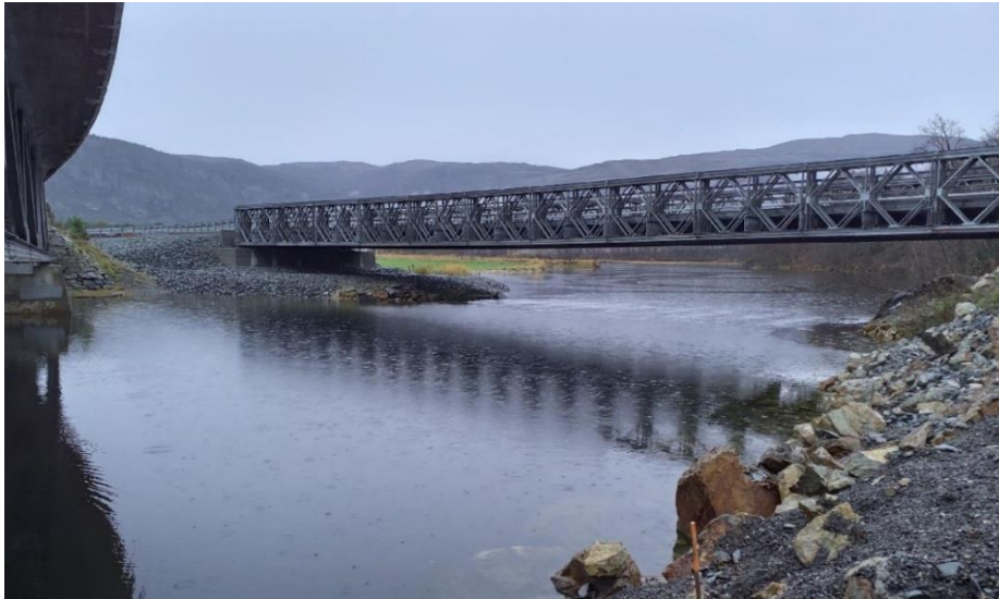
Figur 29: Interimsbru står på fylling i elv. Foto: Statens vegvesen
