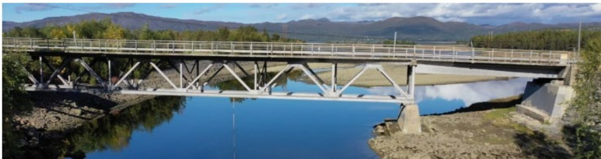
Figur 3–2. Bildet viser den gamle brua, før midlertidig bru ble bygget. Det er stort sett en stålkonstruksjon, med noe betong i fundament på østre breidd. Foto: Statens Vegvesen.
