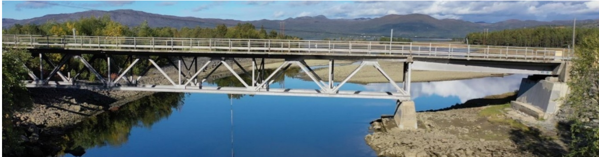
Midlertidig bru til venstre, gammel bru til høyre (10.03.2021):
