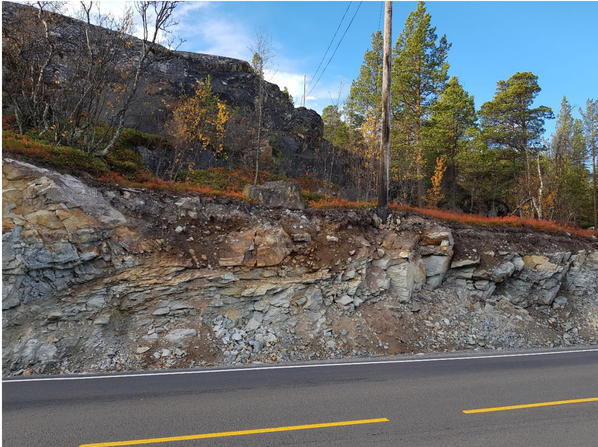
Figur 6 - Bergskjæringen langs interimsvegen for dagens E6 gir et inntrykk av fordeling av løsmassene i området.
