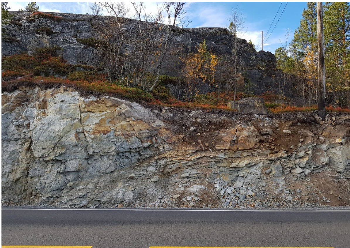
Figur 8 – Bildet er beskrivende for bergmassen i området. I eksisterende bergskjæring for interimsvegen er bergmassen stedvis grovblokkig, men skarpe overganger til høyere sprekketetthet og mer småfallent berg. Berg i bakenforliggende terreng er massivt, med avløste blokker enkelte steder.
