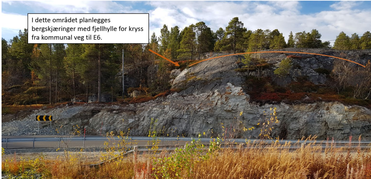
Figur 7 – Bilde av området hvor det planlegges bergskjæringer med fjellhulle. Vegen i bildet er interimsvegen til E6. Bildet tatt mot sør-vest fra gammel bru. Strøk og fall er hovedsakelig tatt i eksisterende bergskjæringen langs interimsvegen til E6.
