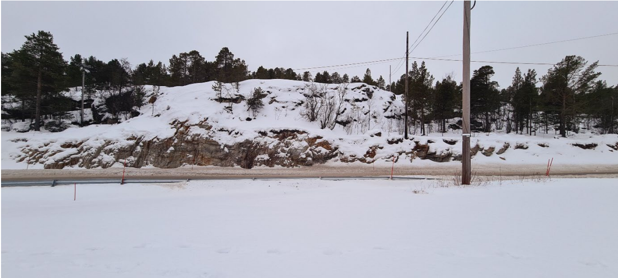
Figur 12 - Vinterbilder av dagens bergskjæring viser lite vann og is. Bildet tatt 26.01.2023.
