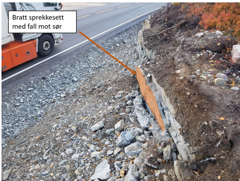
Figur 10 - Bilde av berg i dagen bak eksisterende skjæring til interimsvegen med markering av sprekkesett S1.
