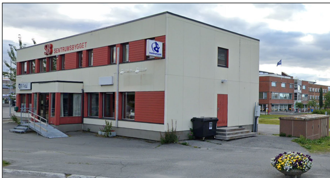
Figur 5 Eksisterende bygg, som er planlagt revet. Kilde: Google maps
