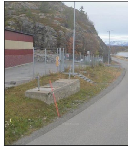
Figur 15: Flere betongkonstruksjoner på vestsiden av vegen er i direkte konflikt med planlagt nytt fortau (Kilde: Google Street View).
