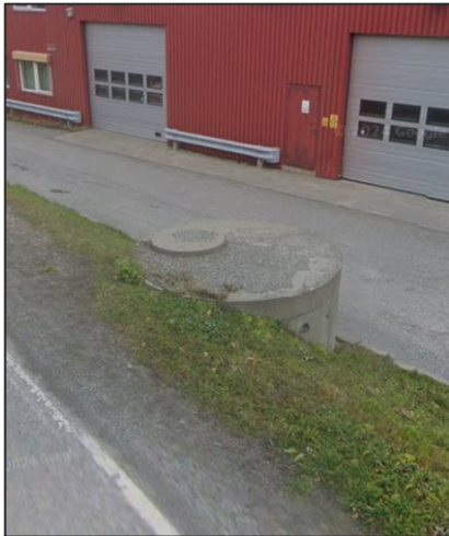
Figur 13: Planlagt rekkverksrom vil ligge delvis over eksisterende betongkonstruksjon på østsiden av vegen (Kilde: Google Street View).
