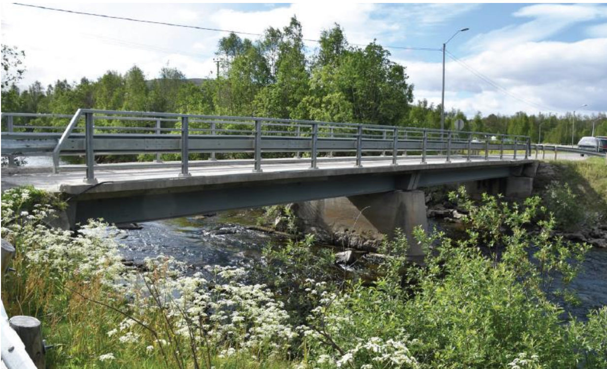
Figur 41: Eksisterende vegbru 20-0665 Bjørnengen.
