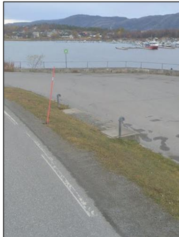
Figur 14: Eksisterende betongkonstruksjon på østsiden av vegen ligger omtrent der det er planlagt ny mur (Kilde: Google Street View).
