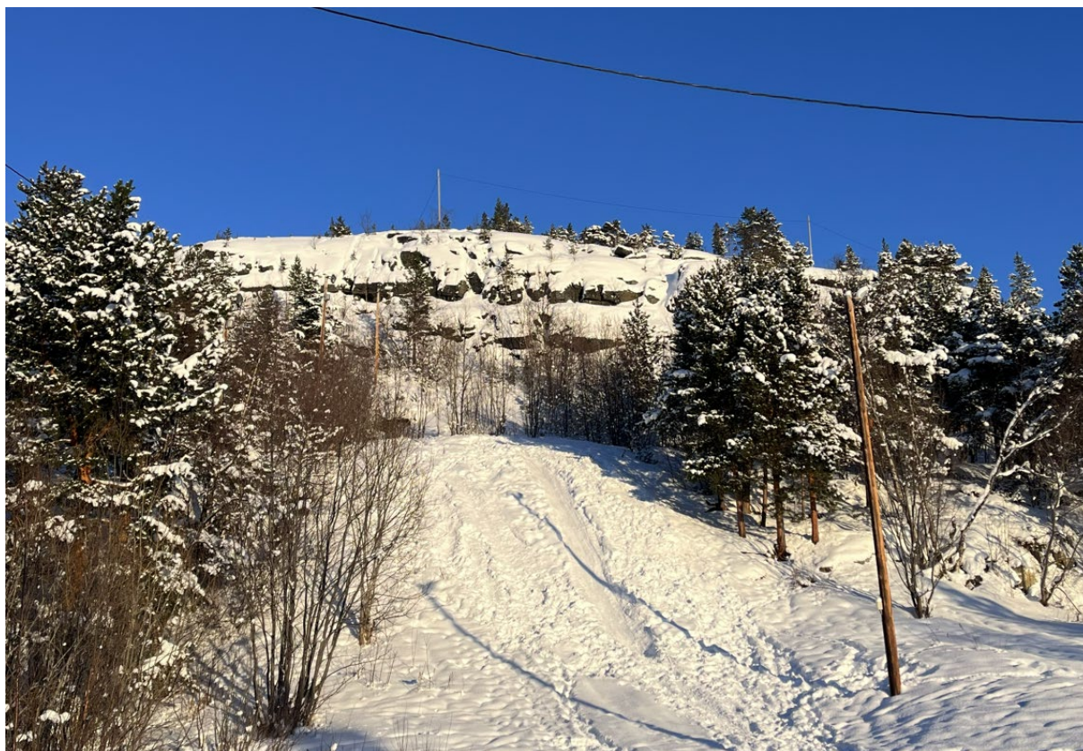
Figur 4 bilde tatt under befarings som viser den aktuelle skråningen. Akebakke ses i forkant av den bratte skrenten.
