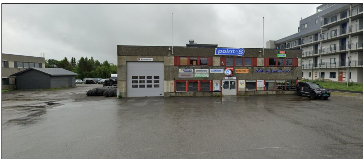
Figur 9 Eksisterende bygg på Markveien 53 og Markveien 55. Byggene er planlagt revet. Kilde: Google Street View
