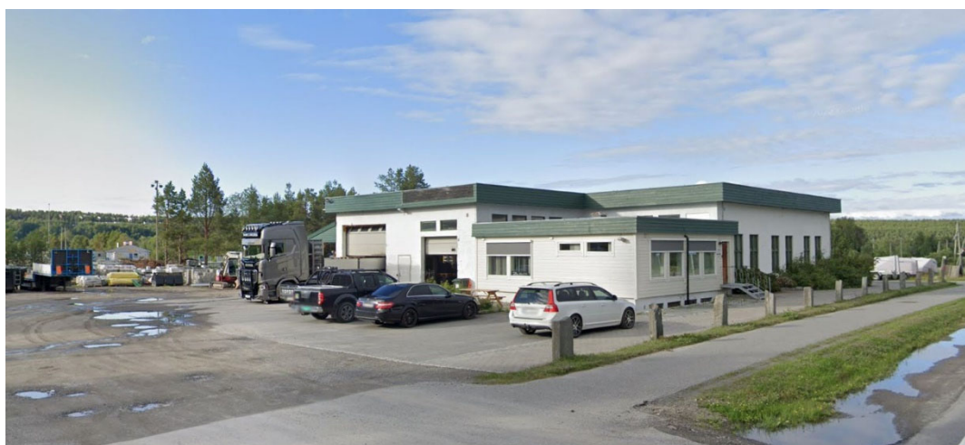
Figur 32 – Anleggsgartnerforetaket ved Aronnesveien (BN).
