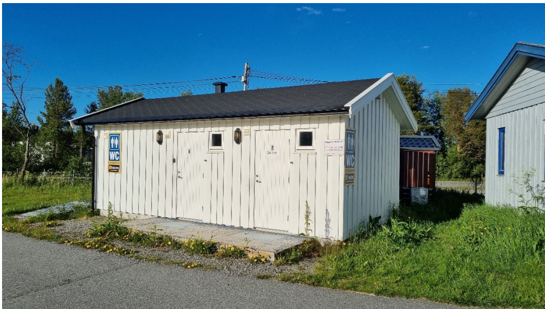
Figur 16 – Sanitærbygget øst i planområdet er av nyere dato, etablert 2018. Dette bygget beholdes. (Bilde 11)
