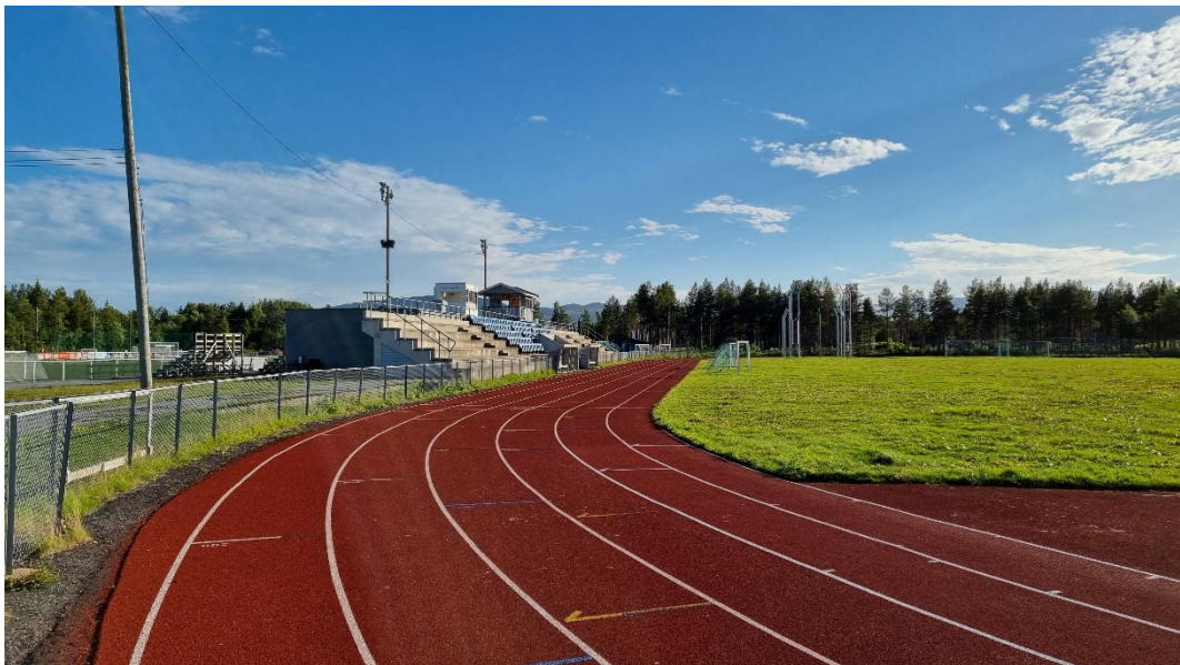
Figur 8 - Friidrettsanlegget med fotballbane i midten. Betongtribune og garderobebygg til venstre. (Bilde 3)
