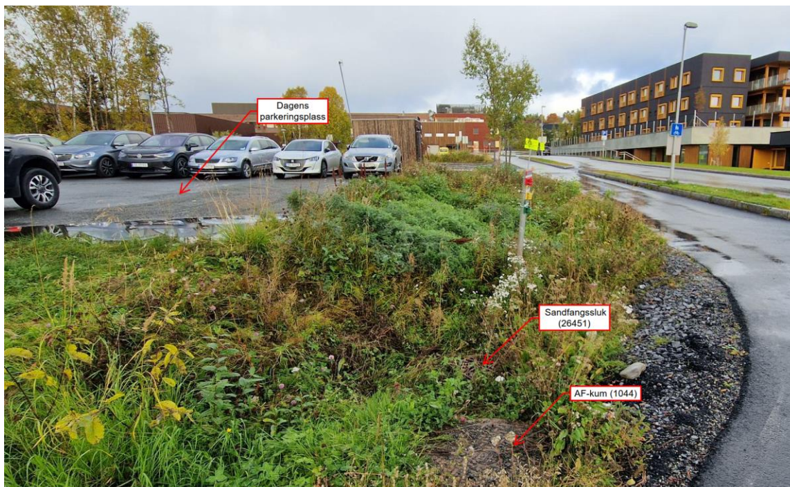
Figur 4-2. Bilde viser dagens parkeringsplass, sandfangsluk og avløp felles kum, etter befarig høst, 2022. Kilde: Rambøll Norge AS, Foto: Jørn Ivar Olsen.
