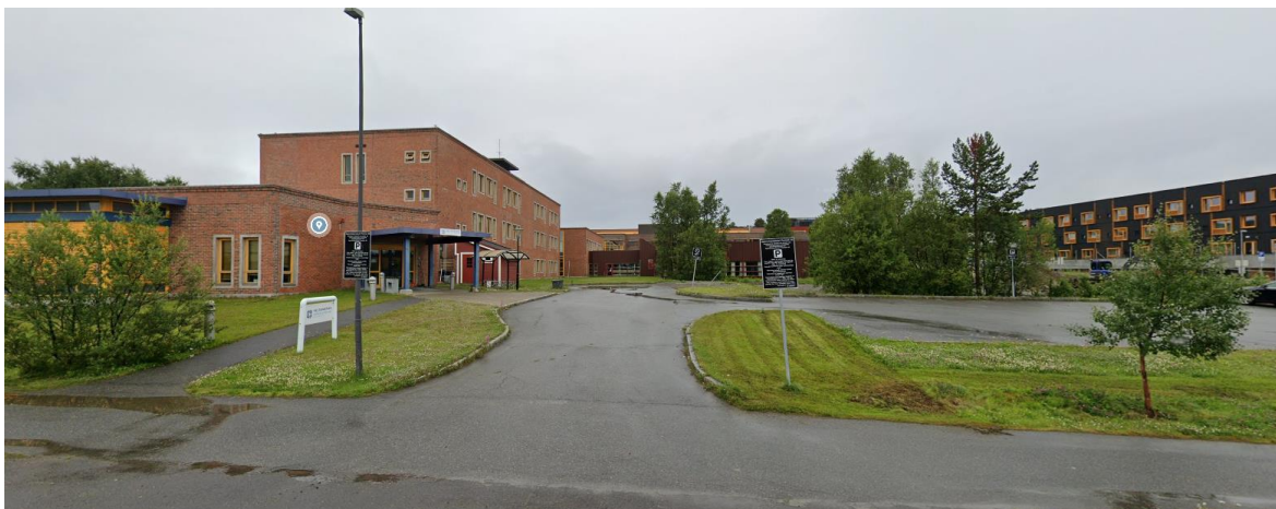
Figur 9 Adkomst til Helsepartner Rehabilitering (tidl. Opptreningscenteret) og eksisterende parkeringsplass. Foto: Google Streetview.
