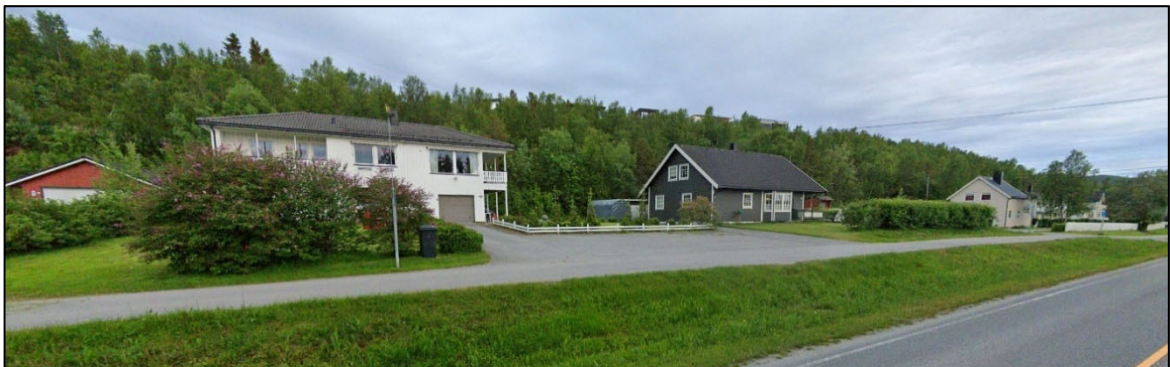
Figur 13 Ulike byggestiler langs E6 i Nerskogen. Bilde: Google Streetview.
