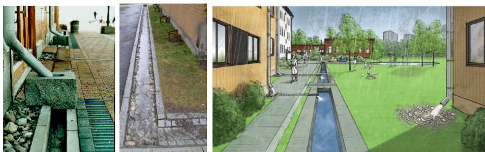
Bilde 7. Venstre: eksempel på et overvannssystem som fører takvannet til en åpen renne. Kilde: Malmø kommune. Midten: Eksempel på åpen renne som fører takvannet videre til en dam/vannspeil. Kilde: Svein O. Åstebøl (COWI AS). Høyre: Illustrasjon som viser hvordan overvann kan håndteres lokalt slik at det både er et funksjonelt tiltak samtidig som et estetisk element i gårdsrommet. Til høyre i bildet føres vann fra tak til terreng slik at vannet kan filtreres i bakken. Til venstre i bildet ledes vann ut i en kanal/renne som ender i en større dam bakerst i bildet. Kilde: VAV.
