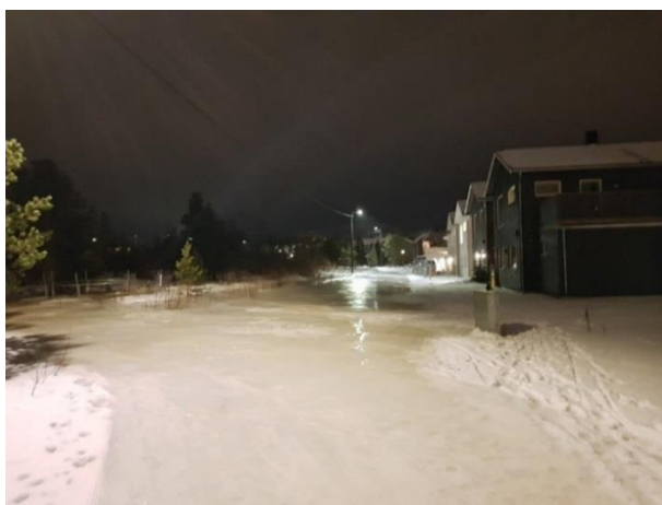
Bilde 3. Isdannelse ved Breverudtunet (sør for BUL-banen), da grøften ble fryst igjen og innløpet til hovedkølverten ble blokkert av is. Bilde: Rambøll Norge AS.
