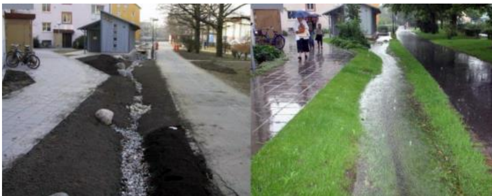
Bilde 5. Eksempel på etablering av vannvei/hovedgrøft i eksisterende bebyggelse. Kilde: Malmö kommune. Hovedgrøften langs Bekkefaret kan åpnes som flomvei ved ekstreme nedbørhendelser.
