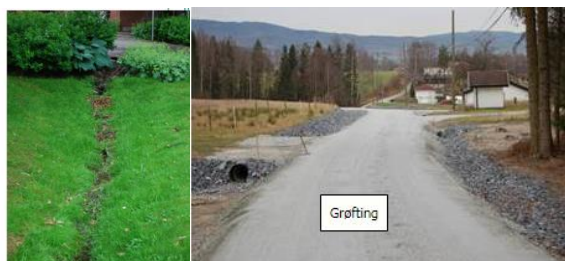
Bilde 6. Venstre: eksempel på vannvei/vadi for å drenere overflatevannet fra private eiendommer. Kilde: Ingrid Merete Ødegård.
