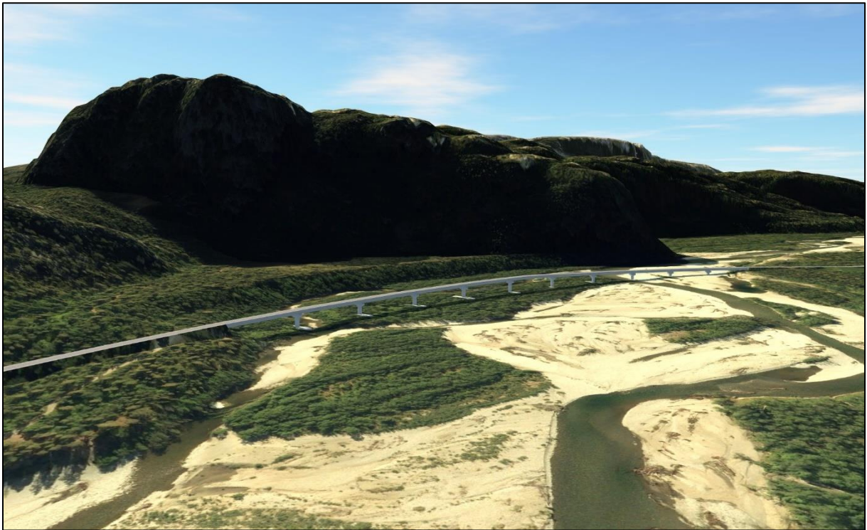
Figur 9. Illustrasjon av kryssing av Eibyelva med bru ca 560 m i alternativ 3 sett fra nord mot sør, med Peskanasen i bakgrunnen. Broen ligger på søyler, men en slik løsning vil trolig ikke bli akseptert i det verna vassdraget. (Statens vegvesen, 2022)
