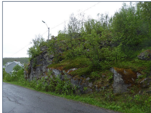
Figur 8. Parti av Klokkarhaugen som er utsatt for steinsprang, men der ny samlevei vil medføre inngrep som sikrer mot framtidige steinsprang. Foto juni 2018: Rambøll
