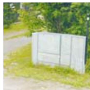
El-skabet er plassert i skjullet mellom to tomter.
