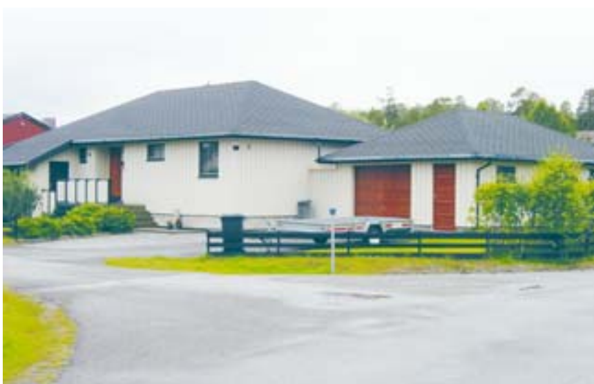
Garasjen har også valmet tak. Tilbyggets takform og -vinkel bør generelt være den samme som på hovedbygget.
