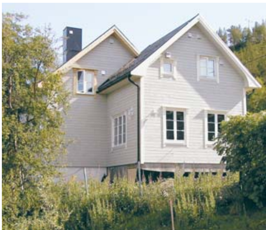
Eksempel på tilbygg til gjenreisningshus. Tilbyggets volum er tilpasset hovedbygget. Tilbygget er forskjøvet i forhold til det opprinnelige bygget.
