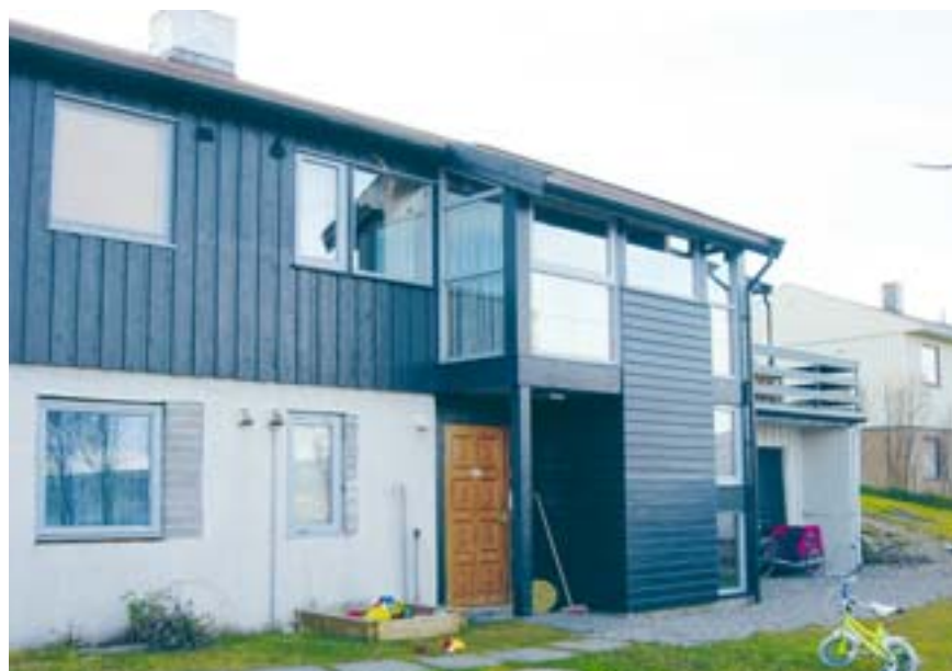
Tilbyggets vinduer og materialer er gitt en moderne utforming. Tilbygget står i kontrast til men spiller også sammen med det eksisterende bygget.
